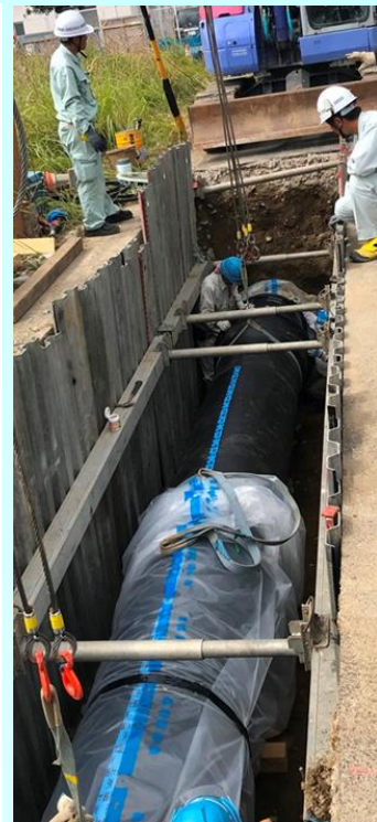
基幹管路更新工事
