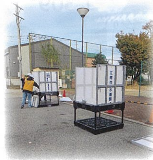
給水タンクの組み立て
