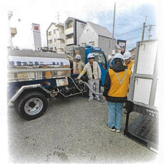
給水車から 給水タンクへの補水
