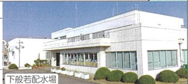
下般若配水場
