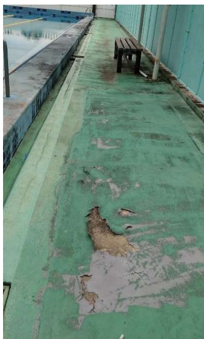
プールサイド(沈下、表層劣化)
