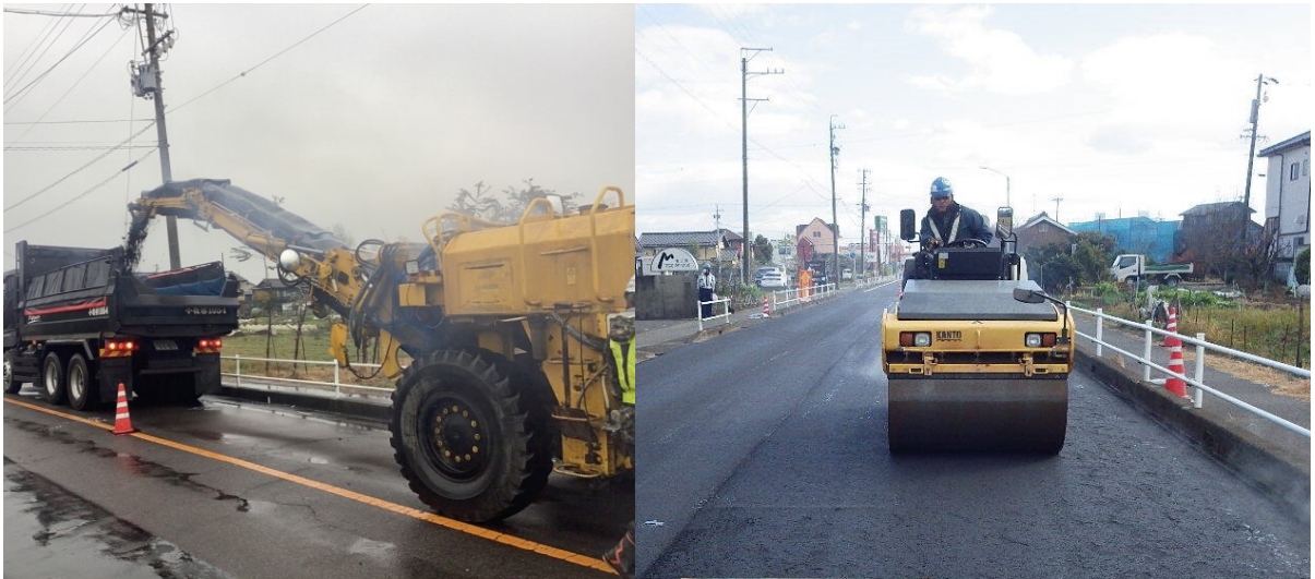
道路の舗装工事
