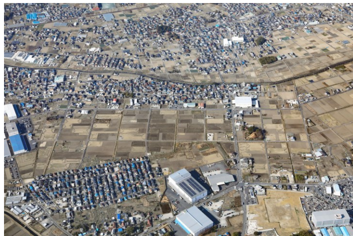
新工業用地整備予定地（曾本地区）
