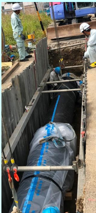
基幹管路更新工事
