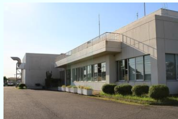
下般若配水場（外観）
