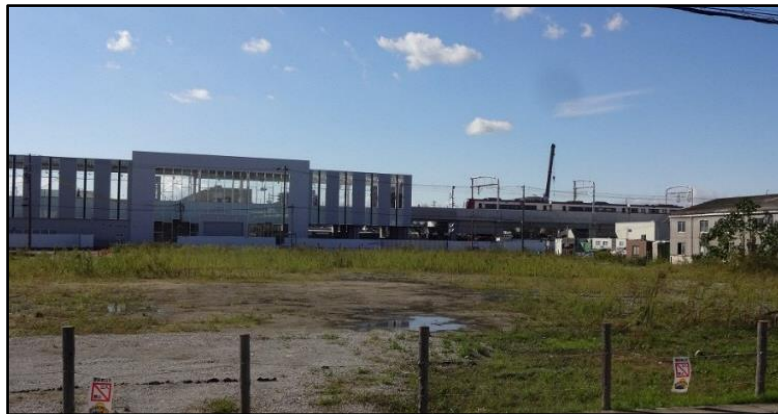
図 1-2 事業対象地の状況 (事業対象地の東側より名鉄布袋駅を望む)
