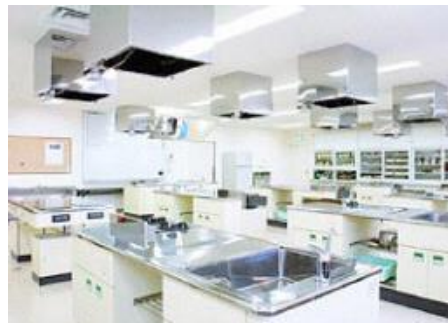
山形市保健センター ヘルシークッキングルーム （「霞城セントラル」、山形県山形市）
