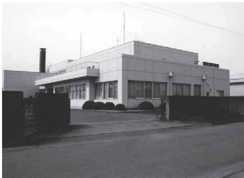
下般若配水場
