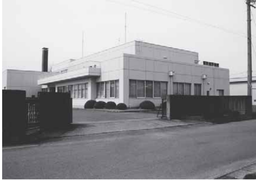
下般若配水場
