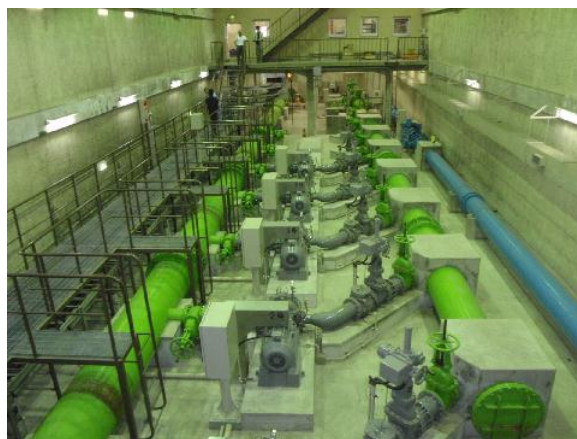
図 2.11 下般若配水場ポンプ室
