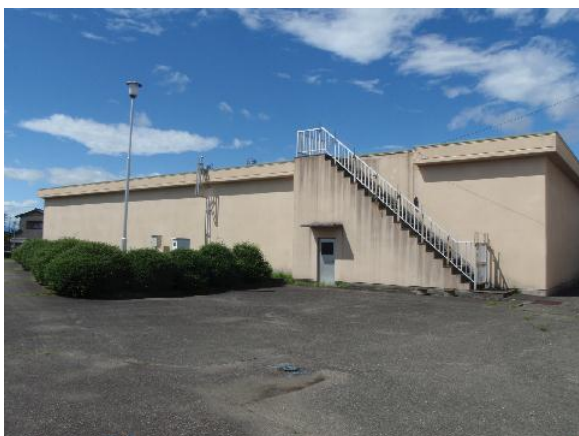
図 2.12 後飛保配水池外観
