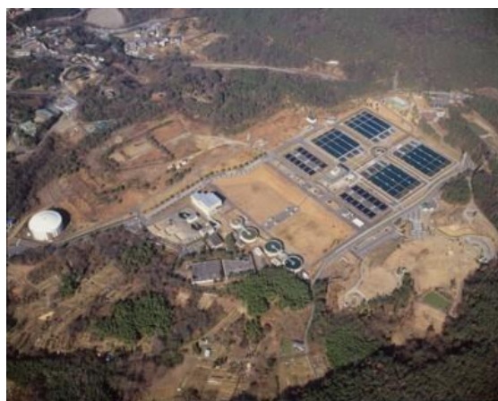
図 2.9 犬山浄水場全景
