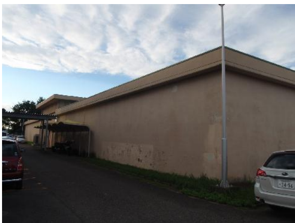
図 2.10 下般若配水池外観
