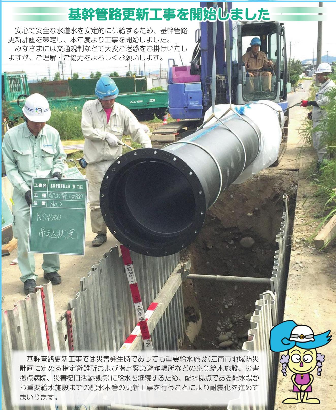
基幹管路更新工事では災害発生時であっても重要給水施設(江南市地域防災計画に定める指定避難所および指定緊急避難場所などの応急給水施設、災害拠点病院、災害復旧活動拠点)に給水を継続するため、配水拠点である配水場から重要給水施設までの配水本管の更新工事を行うことにより耐震化を進めてまいります。
