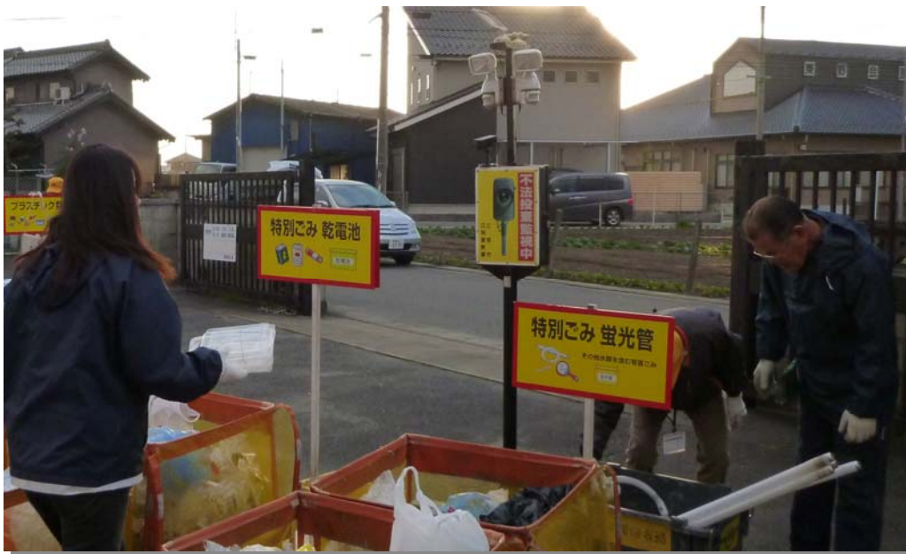
△不法投棄を防止するため、一部の資源ごみ集積所へ不法投棄監視カメラを設置しています。
