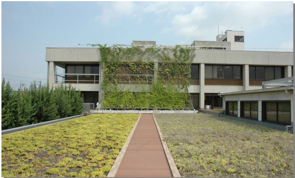
△屋上緑化には、断熱・保温効果があるため冷暖房の使用量を削減でき、また二酸化炭素を吸収する効果もあります。市では、地球温暖化防止のため、市役所西庁舎の屋上を緑化しています。
