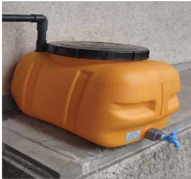
△雨水タンクは、貯めた雨水を花壇にまいたり、洗車に利用できるため、節水になります。また、トイレの流し水などにも利用できるため、災害などの緊急時にも役立ちます。
