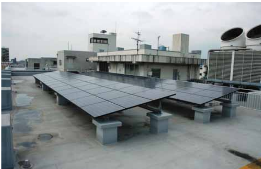
△地球温暖化防止の一環として、市役所の屋上を始め、北部中学校や古知野中学校の体育館の屋根に、太陽光発電システムを設置しています。
