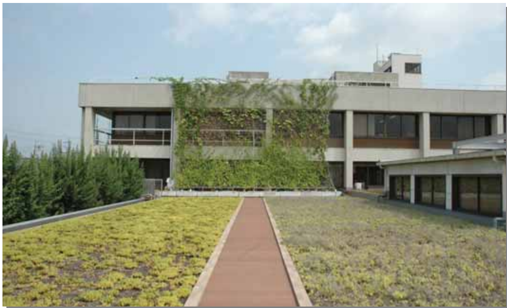
△屋上緑化には、断熱・保温効果があるため冷暖房の使用量を削減でき、また二酸化炭素を吸収する効果もあります。市では、地球温暖化防止のため、市役所西庁舎の屋上を緑化しています。
