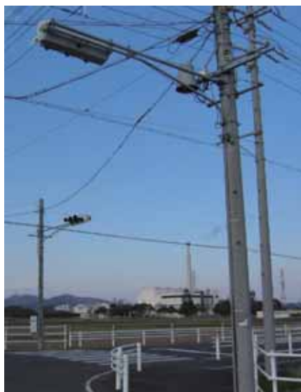
江南丹羽環境管理組合 交差点改良（信号機設置）
