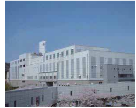
春日井市クリーンセンター 第2工場 59m
