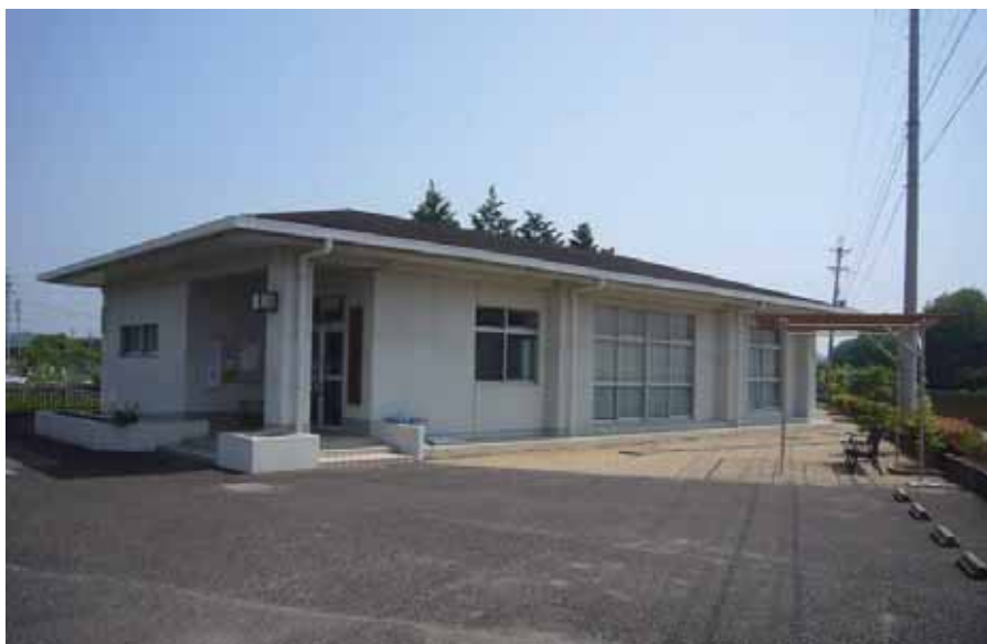
江南市学習等供用施設小協会館
