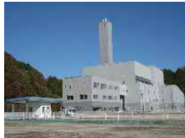
岩手沿岸南部クリーンセンター
