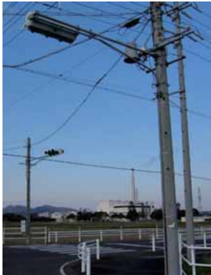
交差点改良(信号機設置)
