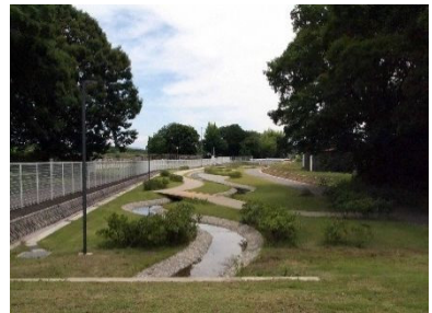
宮田導水路の遊歩道
