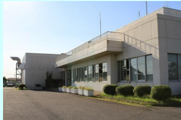
下般若配水場（外観）
