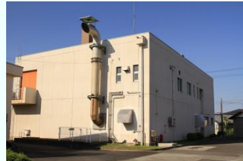
後飛保配水場（外観）
