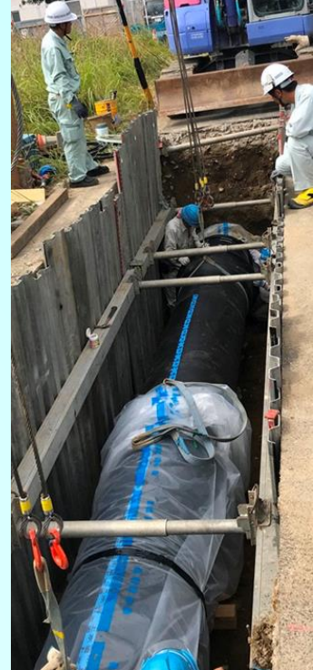
基幹管路更新工事
